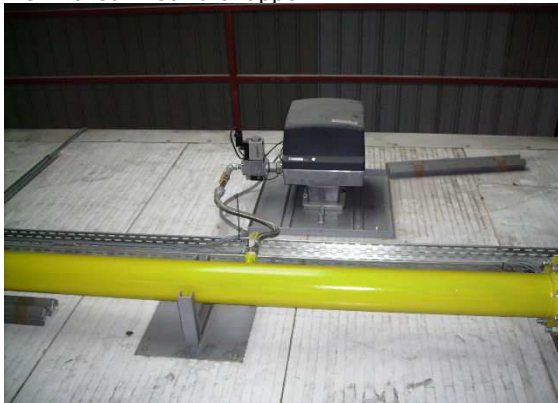
Brennaggregat 350 kW modulierend WEISHAUP
