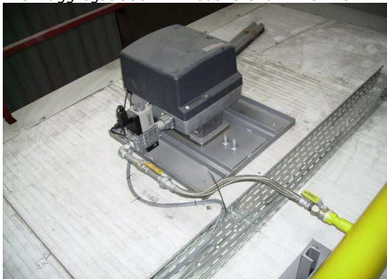
Brennaggregat 350 kW modulierend WEISHAUP
