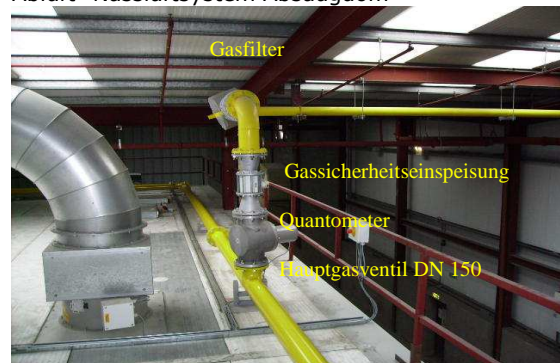
Gashaupteinspeisung DN 150
