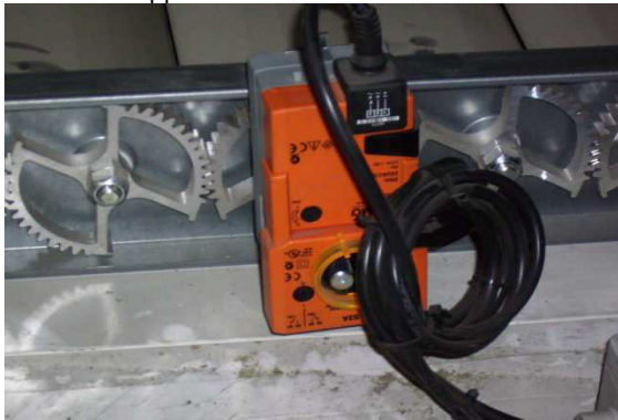
DC Antrieb Frischluftklappe
