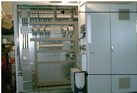
Ausschnitt Laststromverteilung
