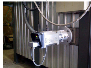
Unterbrenner Hegwein BR1 mit integrierter Flammenüber- wachung im Voll- Teillastbetrieb (100 kW Flammenleistung)
