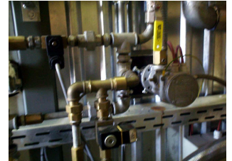
Medienanbindung Gas für Impulsbrenner
