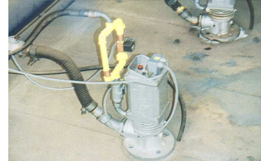
Hochgeschwindigkeitsbrennaggregat für Impulsbetrieb mit integriertem Feuerungsautomat und Impuls/Zündlast- Bypass inklusive automatische Nachzündung bei Brennerausfall.
