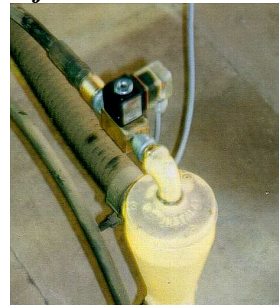
Brennstofflanzen mit Hochleistungsimpulsventil zur Einzelansteuerung und leistungsorientierter Brennstoffzufuhr an jeder einzelnen Brennstelle.
