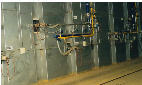
Bild 3: Brennzone rechte Ofenseite mit 3 Brennaggregaten
