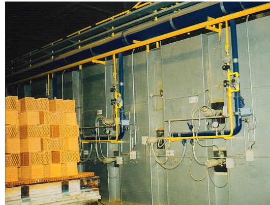
Bild 4: Brenngruppenperipherie mit TOW-Besatz
