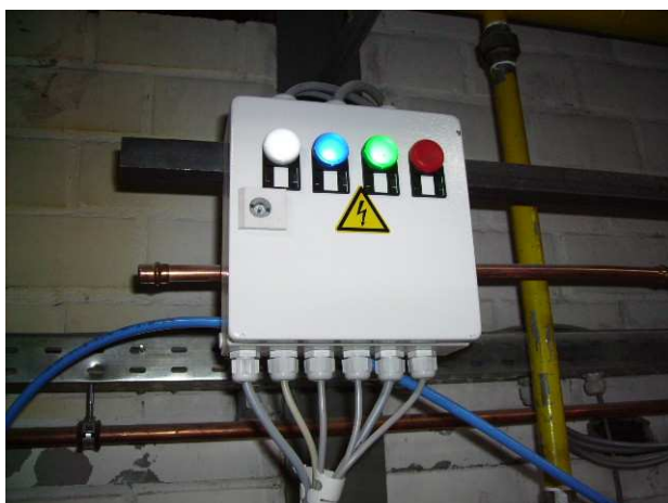
Schnittstellenverteiler zur Brennstelle
