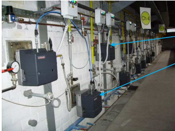
Brenneranordnung linke Ofenseite
