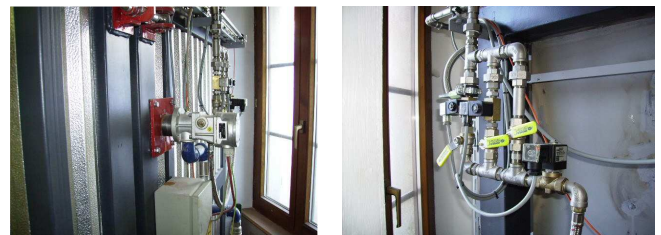
Bild 17. Umrüstung Kammerofen impulsbefeuet auf LAMBDA Automatik
