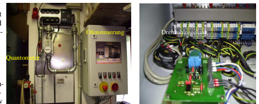
Bild 17. Umrüstung Kammerofen impulsbefeuet auf LAMBDA Automatik
